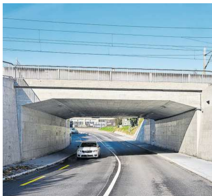
Die Sanierung der SBB-Unterführung Feldeck in Schönenwerd ist fertig. Bild: José R. Martinez
